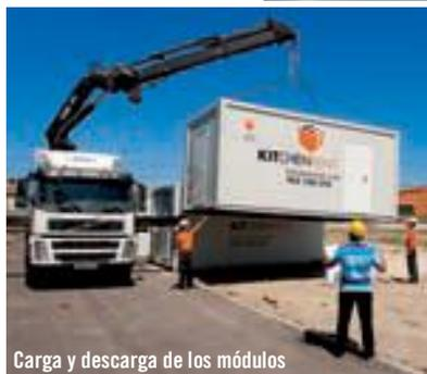
Carga y descarga de los módulos
